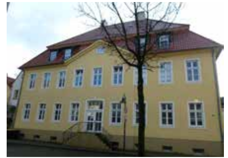
Haus Residenzstraße 23 mit Mansarddach und Giebelrisalit
