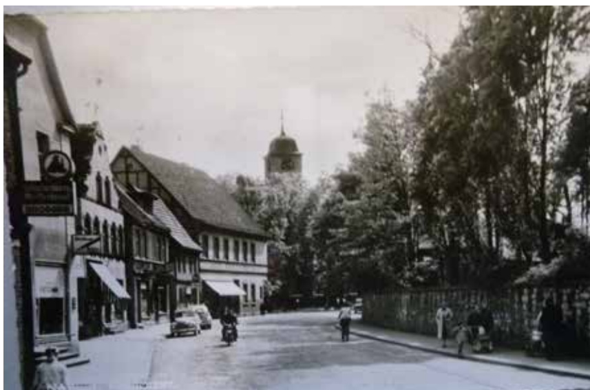
Residenzstraße mit der alten Schlossmauer, bevor diese zur Straßenverbreiterung versetzt wurde
