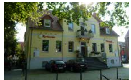
Haus Residenzstraße 19 mit Zwerchhaus
