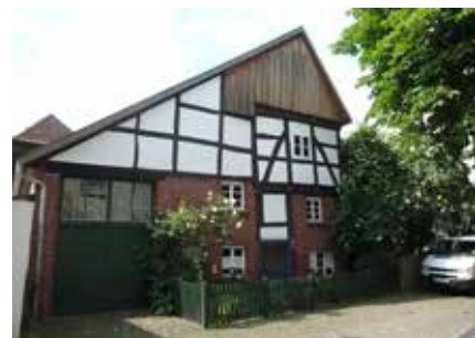
Haus Neuhäuser Kirchstraße 16
