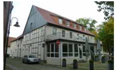
Haus Sertürnerstraße 2 mit Putzfassade
