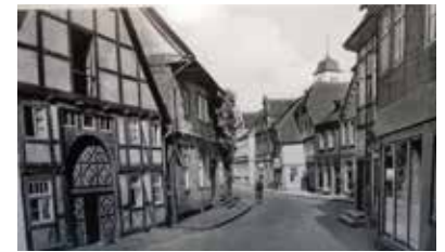
Blick in die Residenzstraße vor den Abrissen und Umbauten und unten heute
