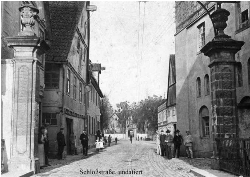
Historische Situation der Pylone an der Mühlenenge, Schloßstraße
