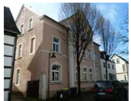
Haus Neuhäuser Kirchstraße 3 mit Zwerchhaus
