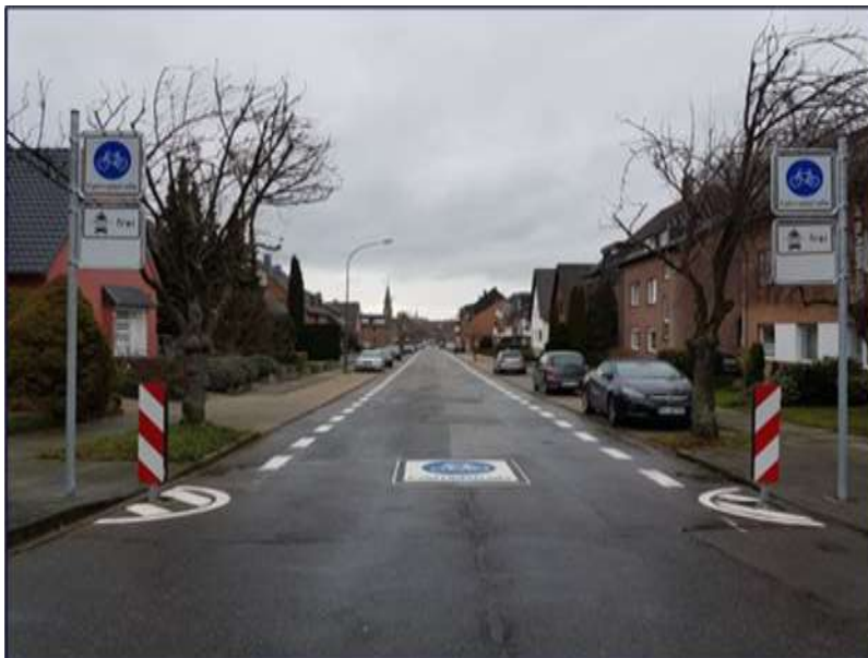
Abbildung 6: Tor-Situation durch beidseitige Anordnung des VZ 244.1 in Kombination mit Sperrflächen und Schraffenbaken (VZ 605-10 u.-20) (Bildquelle: Stadt Aachen)
