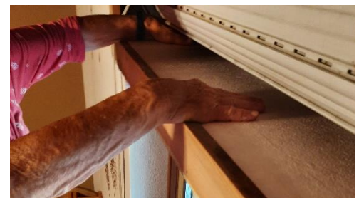
Abbildung 14: Einpassen der Platte
