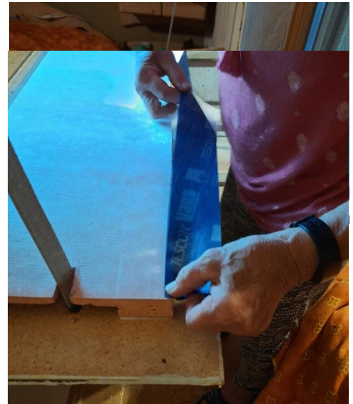
Abbildung 19: Die Dämmplatte ist an verschiedenen Stellen ausgeschnitten. Aufkleben eines Kantenschutzes.
