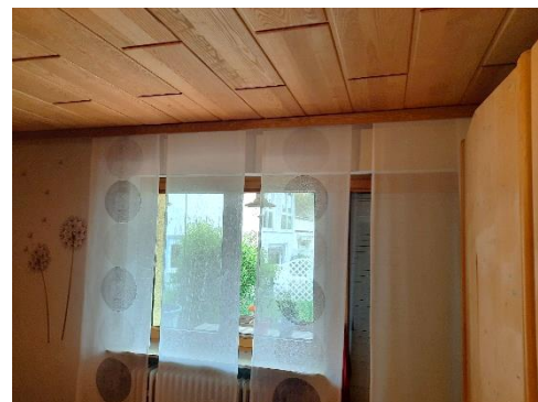
Abbildung 1: Ausgangssituation – Der Kasten enthält einen Rollladen für das Fenster und einen für die Türe.
