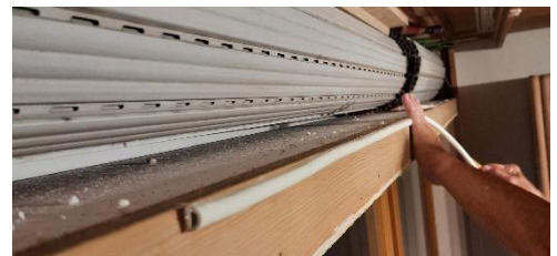
Abbildung 20: Luftdichtheitsband aufkleben.
