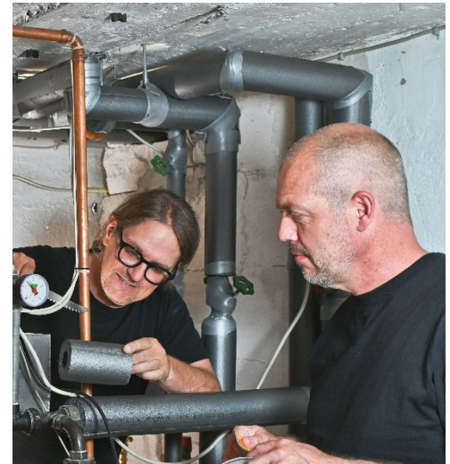
Abbildung 2: Sparen durch Leitungsdämmung. So geht's: DIY-Anleitung „Warme Rohre dämmen“
