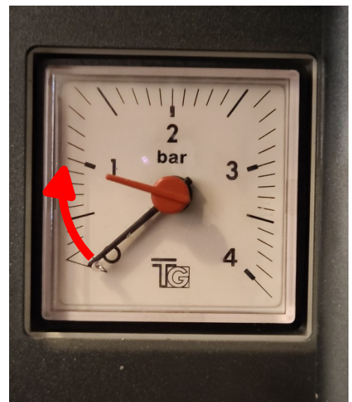
Abbildung 6: Druck kontrollieren und gegebenenfalls Heizungswasser nachfüllen.
