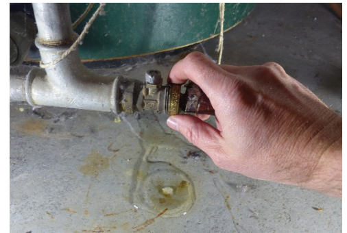
Abbildung 7: Heizung und Trinkwassernetz zum Nachfüllen verbinden
