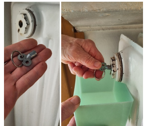
Abbildung 8: Heizkörper entlüften
