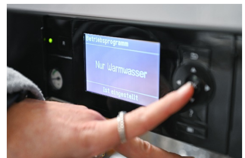
Abbildung 11: Sommerbetrieb einstellen: Nur Warmwasser
