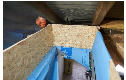
Abbildung 10: Rahmen montieren und mit luftdichter Schicht verbinden
