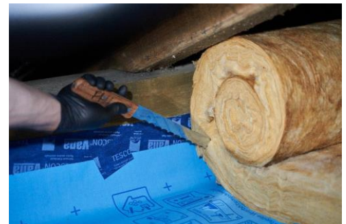
Abbildung 14: Länge mit Dämmstoffmesser oder Filzstift markieren
