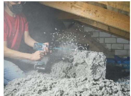
Abbildung 19: „Abfräsen“ des Zelluloseballens mit Akkuschauber und Rühraufsatz
