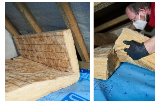
Abbildung 15: Klemmfilz zurück ziehen, und in einem Bereich das Daches schneiden, in dem genug Platz ist. Achtung, beschädige dabei die luftdichte Schicht nicht, lege am besten etwas unter!
