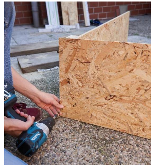
Abbildung 9: Rahmen zusammenschrauben
