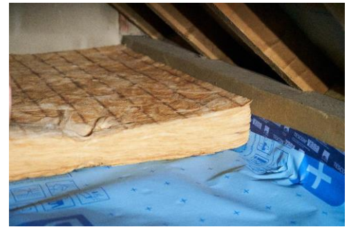
Abbildung 13: Erste Klemmfilzlage ausrollen
