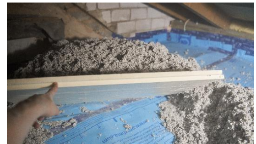
Abbildung 19: Zellulose zum Einbauort schieben
