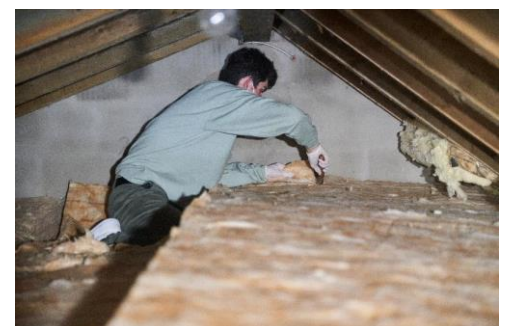
Abbildung 16: Aufbringen der zweiten Lage Filz
