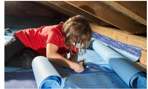
Abbildung 5: Ablängen der luftdichten Bahnen
