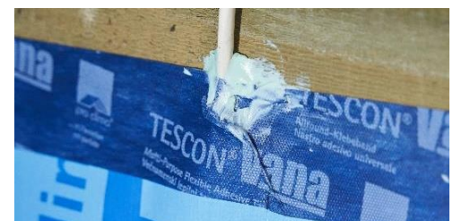
Abbildung 8: Kabeldurchführung
