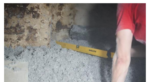
Abbildung 20: Zellulose geradeziehen
