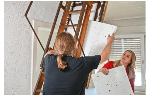
Abbildung 8: Einpuzzeln der zweiten Dämmschicht.
