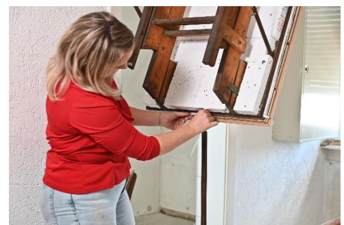
Abbildung 9: Schaumstoffdichtband aufkleben.
