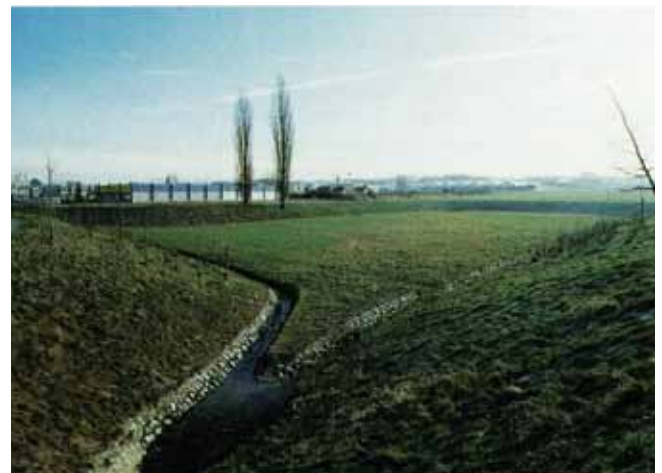
Hochwasser-Rückhaltebecken Benhauser Straße – auch ein Baustein des regionalen Hochwasser-Schutzkonzeptes
