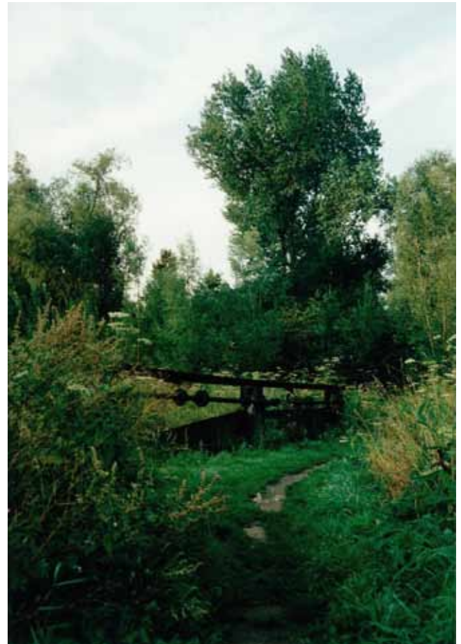
Mit solchen Stauwehren wurde der Wasserstand in den Flößgräben reguliert.
